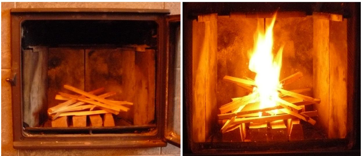
**Bild 13:** Die Methode „Anfeuern ohne Rauch“ wurde vor wenigen Jahren in der Schweiz entwickelt und ermöglicht eine deutliche Schadstoffreduzierung bei Stückholzfeuerungen. Die großen Holzstücke werden unten aufgelegt, oben die kleinen. Das Feuer wird mit einem Zündwürfel oben angefacht. Suchwörter wie „Richtig Anfeuern“, „Neue Anfeuerungsmethode“, „Anfeuern ohne Rauch“ etc. in einer Internet-Suchmaschine führen zu weiteren Informationen zur schadstoffarmen Zündung des Kaminfeuers.
